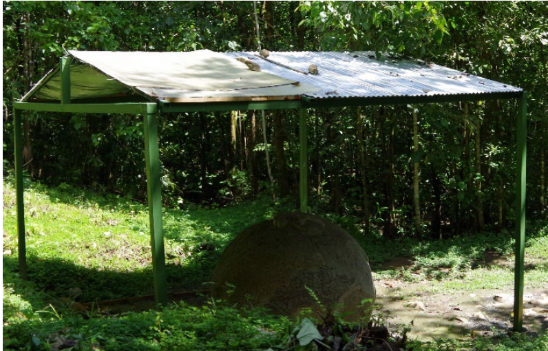
Año 2019 – Proceso de instalación de zinc
