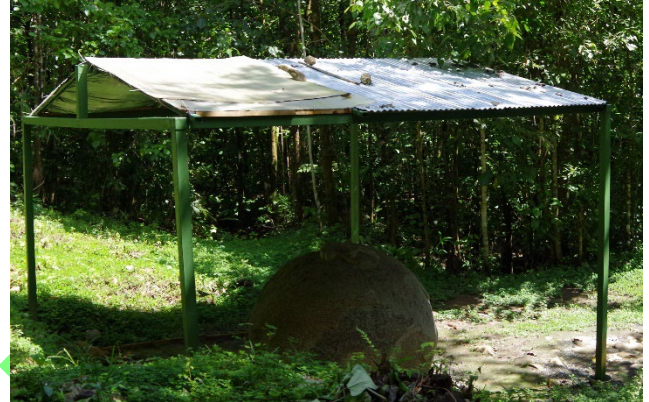
Año 2019 – Proceso de instalación de zinc
