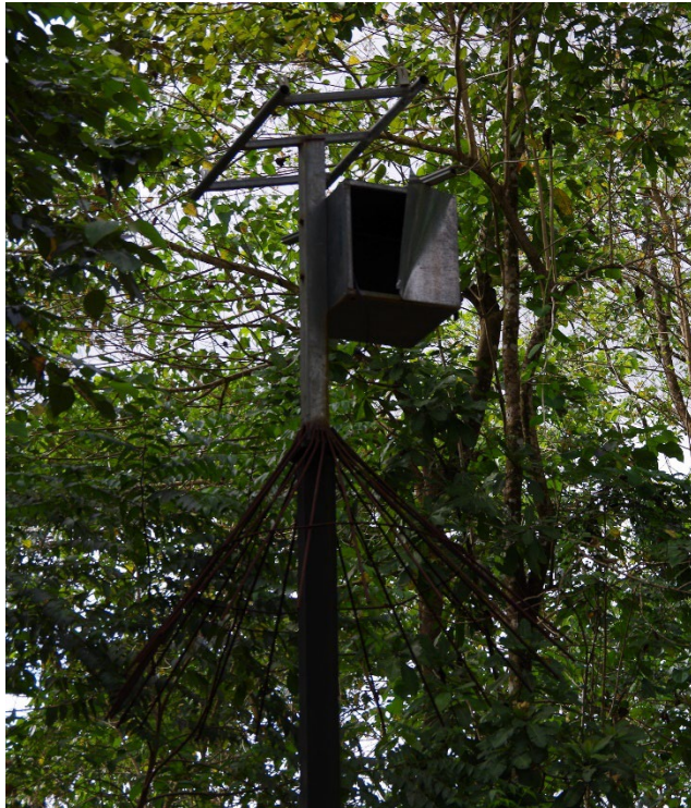
Restos de la instalación del panel solar
